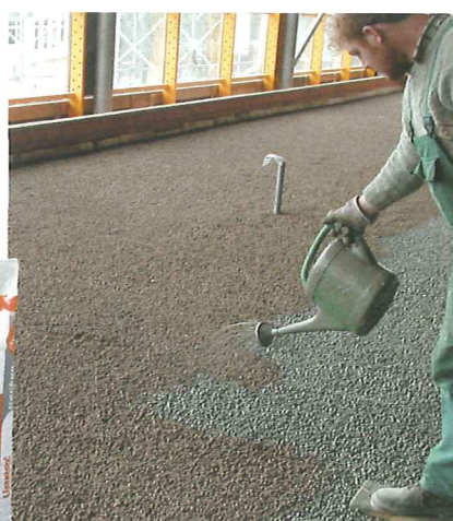
na betonovém stropě pod betonovou plovoucí podlahou s dodatečnou tepelnou izolací a s uložením rozvodů sítí
